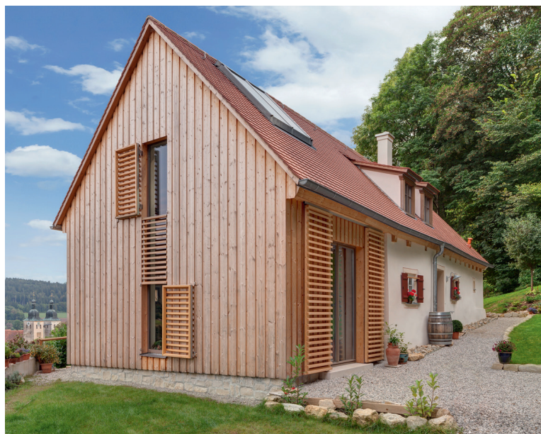
◆ Wohnstallhaus in Plankstetten, Lkr. Neumarkt i. d. OPf., Staatspreis 2017
