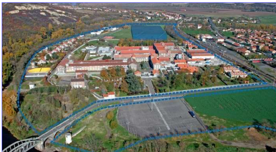
Das Gelände der Papierfabrik in Longues (blau umrahmt das geplante Erweiterungsprojekt)
