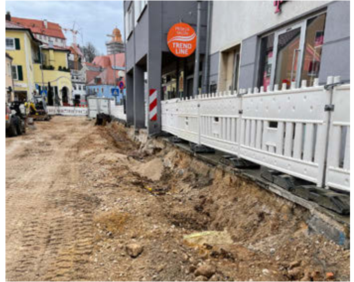
Bauarbeiten Dr.-Boecale-Straße, IB Roland Lehner Parsberg
