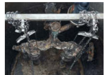
Stark verschmutzt: Revisionsschacht und Hauptpumpstation
