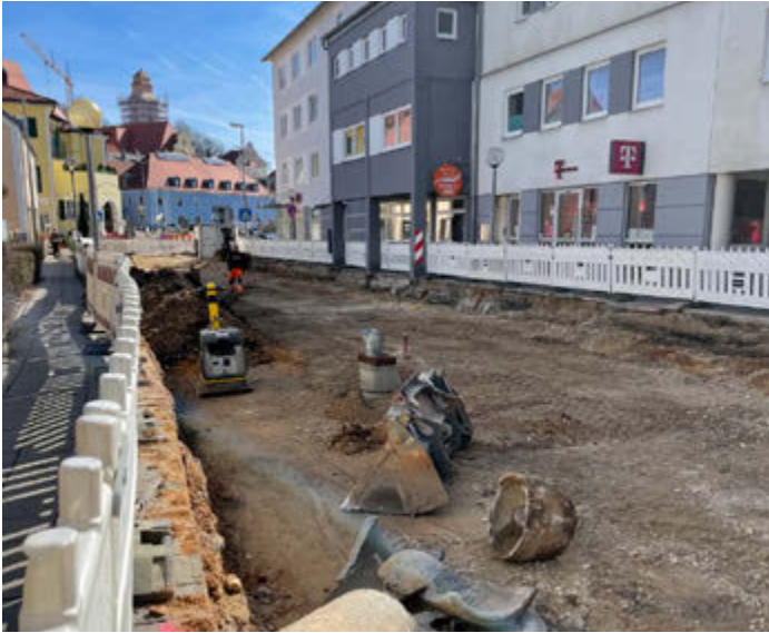
Bauarbeiten Dr.-Boecale-Straße, IB Roland Lehner Parsberg
