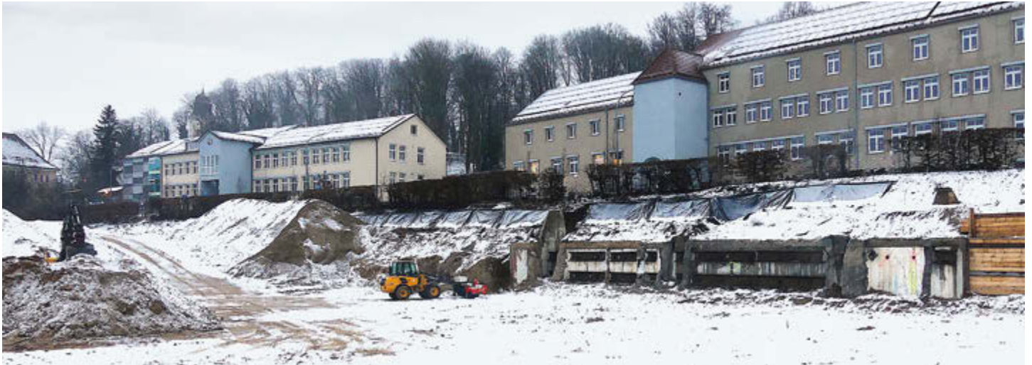
Ein Blick auf das Baufeld, das einst das unterirdische Hilfskrankenhaus beherbergte.
