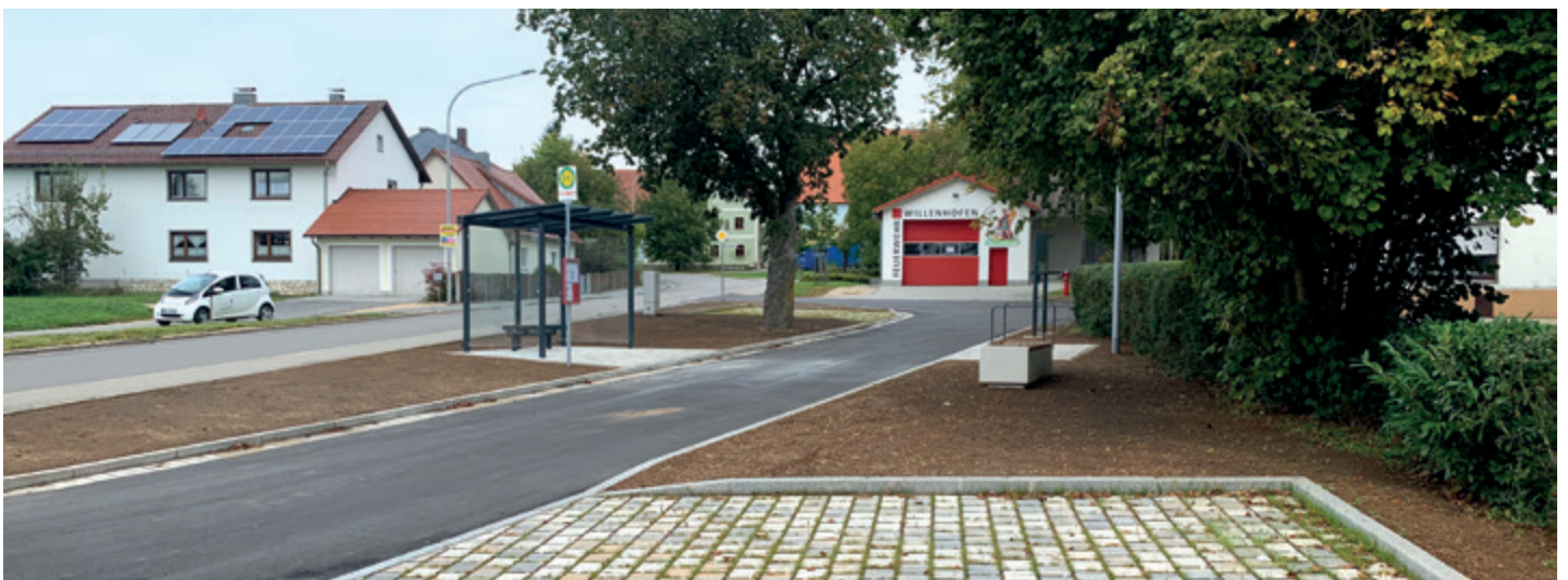
Die Sanierung der Bushaltestelle als Abschluss der Dorferneuerung in Willenhofen
