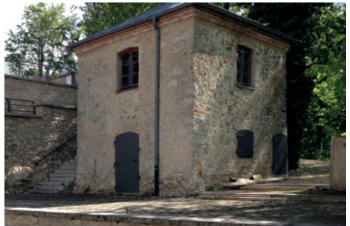
Der Steinpavillon im Burggarten
