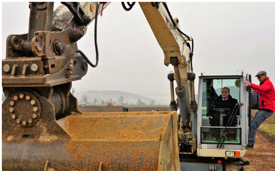
Auch ein bayerischer Finanzminister versteht es, mit einem Bagger umzugehen
