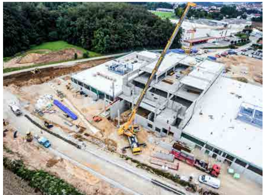
Luftaufnahme der Baustelle „Möbelhof Parsberg“
